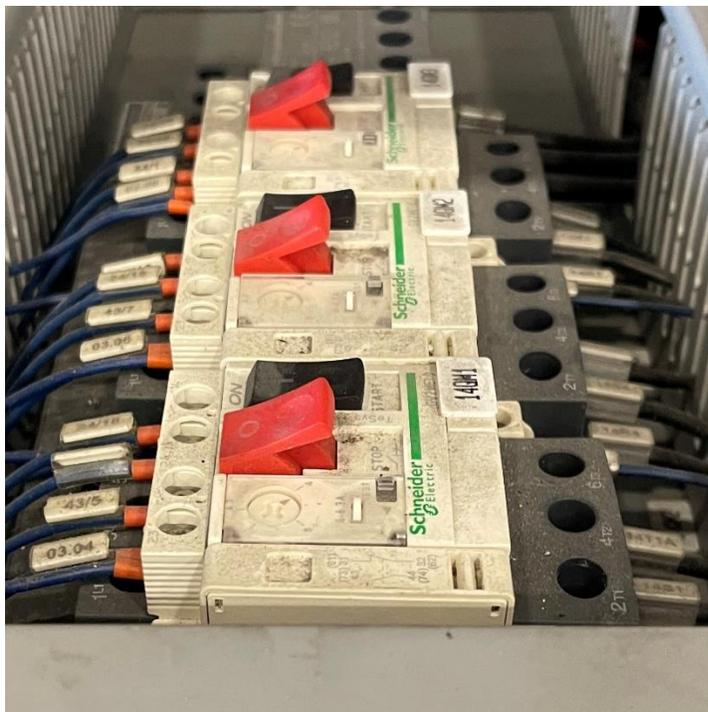
**Alarma de motores:** En caso de que aparezca una alarma de los motores en la pantalla, se debe abrir la maquina y verificar si algunos de los interruptores se disparo, todos los brakes deben tener la parte roja arriba y la parte negra hacia abajo.
